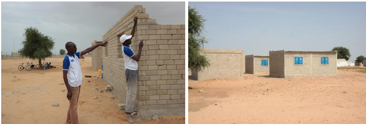
Exemples des deux techniques de construction – Traditionnelle “construction sans bois” (Chetimari – maisons 18m 2 ) and “Construction Hydraform” (Diffa – maisons 24.5m 2 ). Les deux techniques sont adaptées au contexte et respectueuse de l’environnement (UNHCR).
