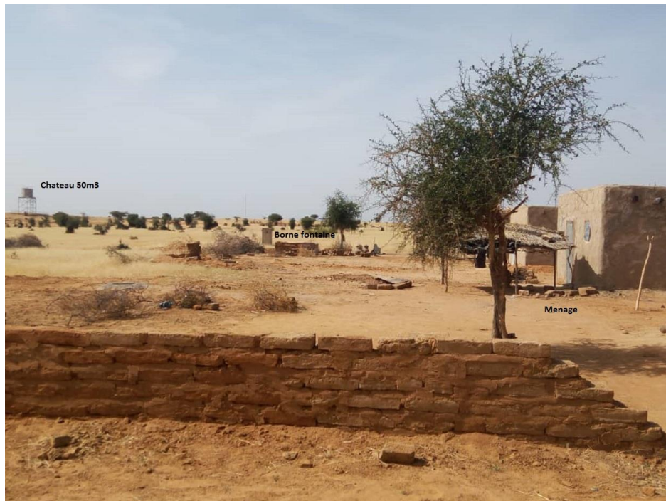
Infrastructures hydrauliques – Site urbanisé d'Ayorou
