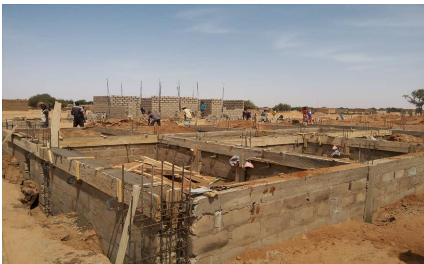
Site de construction du CSI de type II d'Abala
