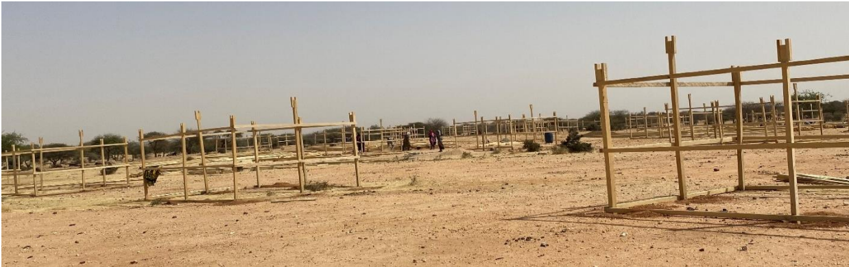
Construction d'abris d'urgence pour les familles dans le camp de Kouchaguine-Moura©UNHCR/E. Umutesi
