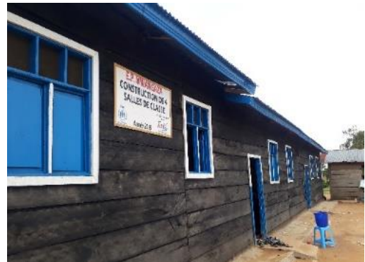
Les salles de classe construites par AIDES, partenaire du HCR, pour les enfants déplacés internes à Oicha, en Province du Nord-Kivu. © AIDES/S. Muhigwa
